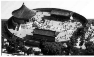
图 2-3-7 天坛的回音壁。人站在圆形围墙内附近说话，声音经过多次反射，可以在围墙的任何位置听到。
